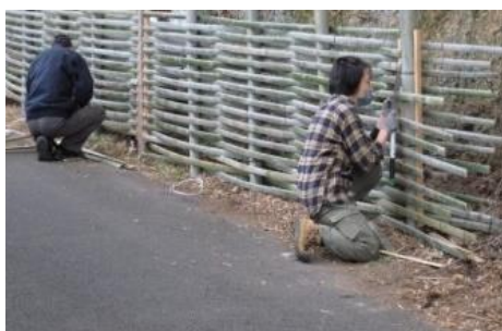
市道脇に竹垣を設置し、土砂流出防止・景観向上を図っている
