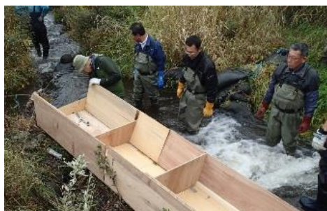
ポータブル魚道の設置
