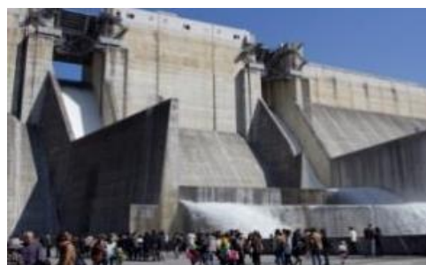
尾原ダムクレストゲート点検放流風景
